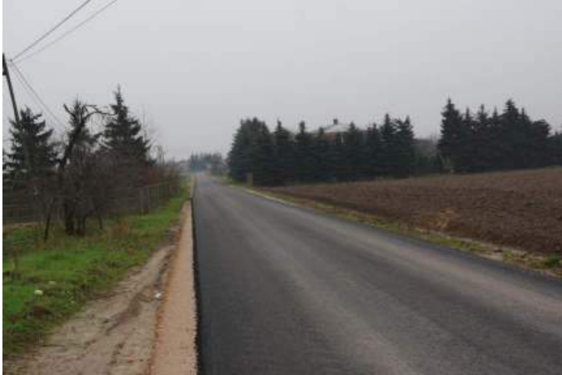
Droga gminna w miejscowości Radzanowo - Dębniaki
