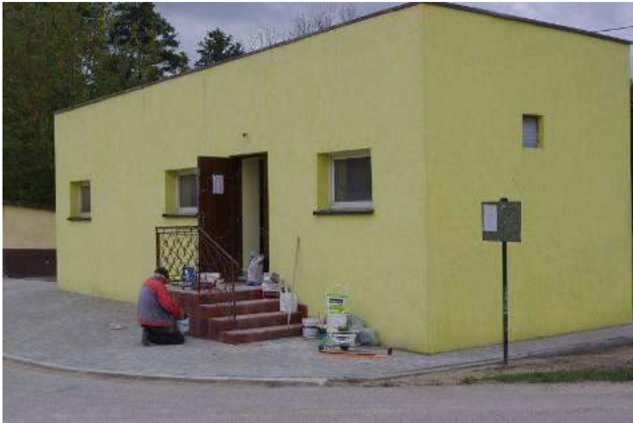
Świetlica wiejska w Czerniewie
